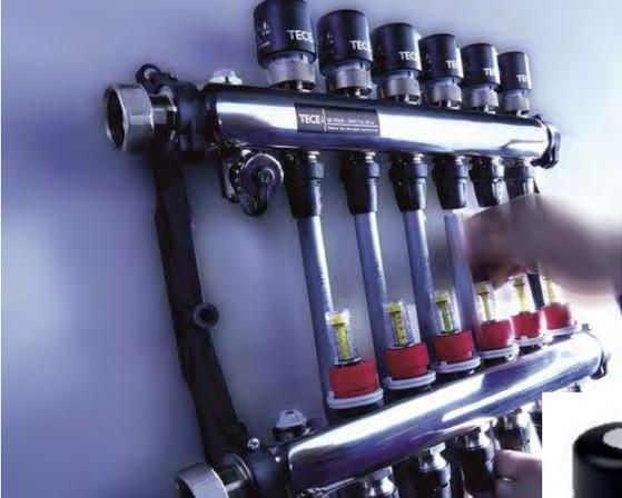
**TECEfloor Edelstahl-Heizkreisverteiler mit Durchflussanzeige**
